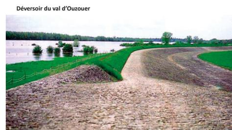
D'autre part, cette cote ne doit pas être trop élevée car cela serait prendre le risque de ruptures de digues sur le reste du linéaire avant le fonctionnement de la surverse, ce qui serait totalement contraire à l'objectif même de cet aménagement.
