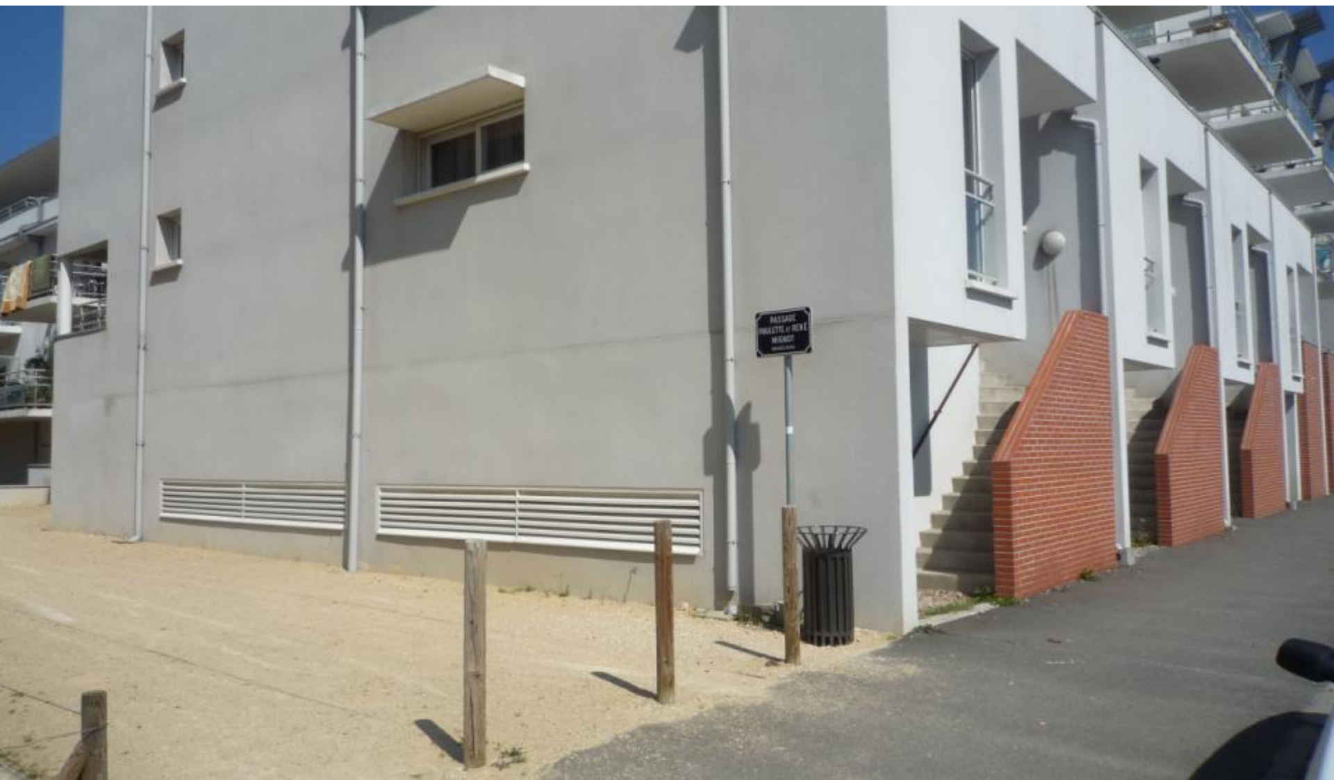
Rez de chaussée non habité
