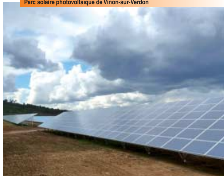
Parc solaire photovoltaïque de Vinon-sur-Verdon
