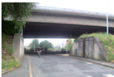
Passage de voitures dans la levée du canal, on aperçoit les rails pour le batardeau en cas d'inondation
