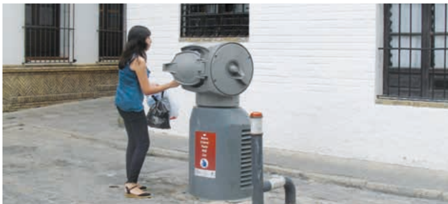
Borne d'aspiration à Séville ©ATU
